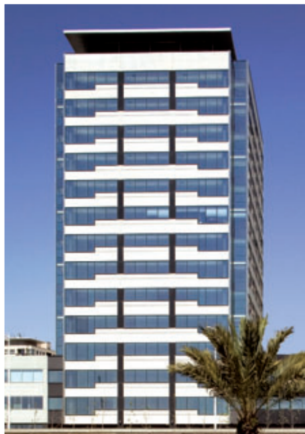
ILLA TERCIARI - DIAGONAL MAR (BARCELONA) Aplicación MetalCleaner y Oxistop en esquineros de fachada de acero inox - 372 m 2
